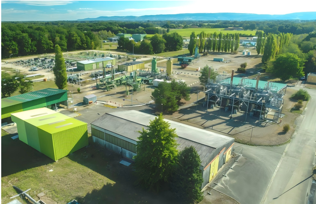
Fig. 3 HypSTER site photo ( https://www.h2-mobile.fr/actus/hypster-premier-site-francais-cavite-saline-devient-realite/ )
